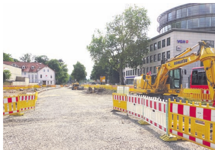
Die Baustelle Berliner Straße.
